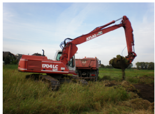
Bau von Grabentaschen
