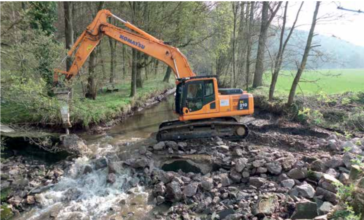
Wiederherstellung der Durchgängigkeit einesw Gewässers (Foto: Joachim Wöhler)
