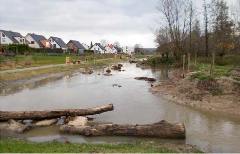
Renaturierung der Werre in der Stadt Detmold durch Schaffung eines neuen Gewässerverlaufes mit Aktivierung der Gewässeraue.
