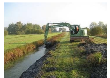
Grabenräumung in den Kirchwerder Wiesen
