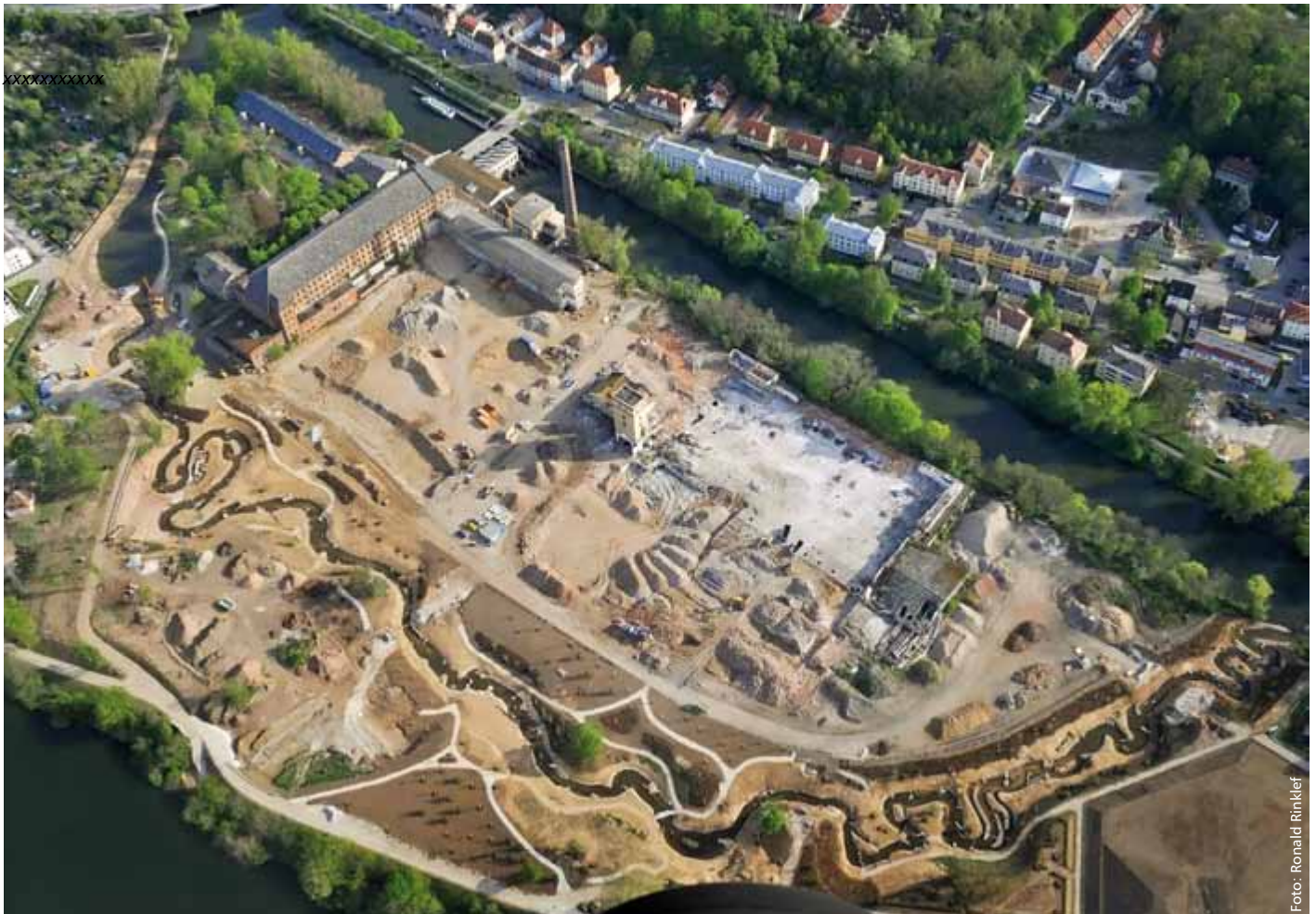
Baustelle Landesgartenschau 2012: Gut erkennbar – der geschlängelte Fischpass
